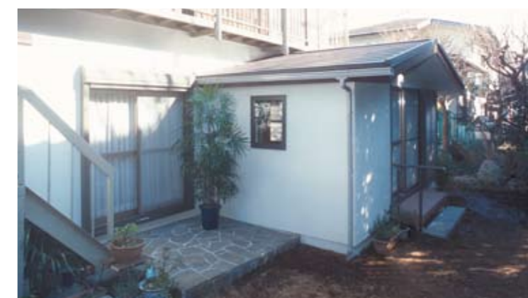
切り妻の形状で増築、天井、止めの形状を工夫しました
