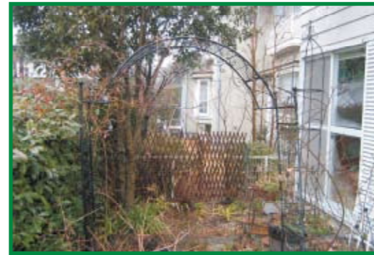
町田市 U様邸テラス工事 《担当者》町田店/古市 圭太 ◎リフォーム期間/約3日
