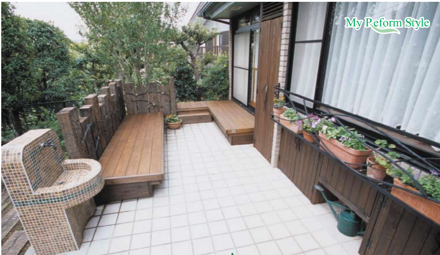
お母様の為にテラスへの段差を和らげるウッドデッキを造作。 枕木による装飾と可愛いガーデン水栓・手作り収納扉がポイントです。
