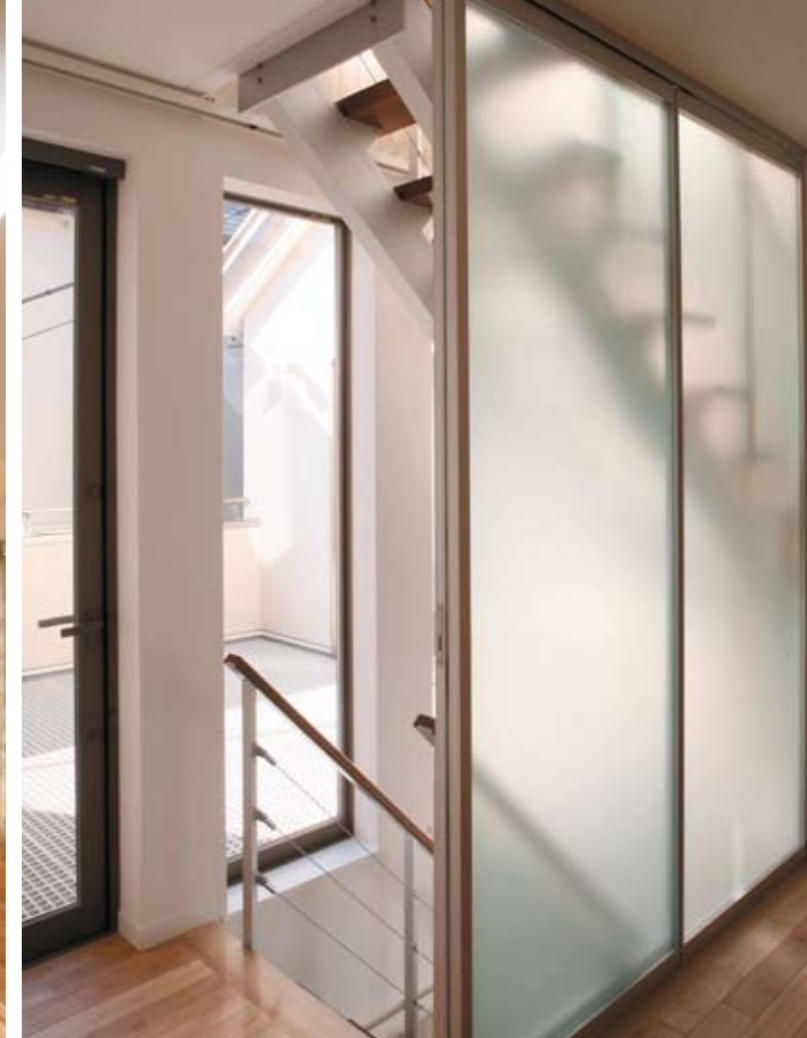
お互いの気配が感じられるように設計された、吹き抜けの階段ホール。 アルミ階段と強化ガラスのパネルが、光と風を気持ちよく通します
