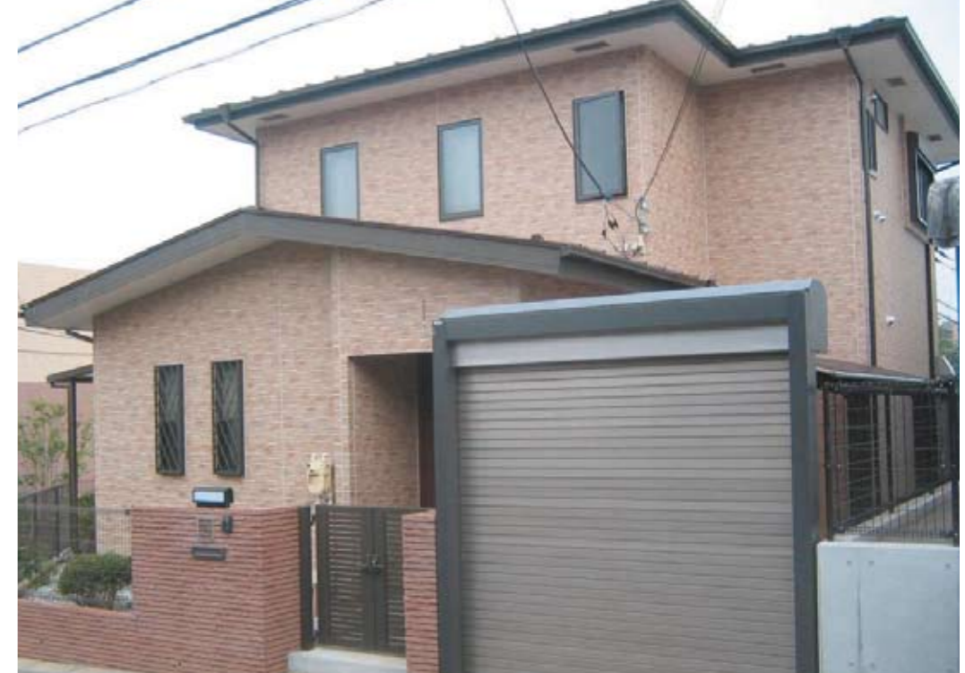
築30年の住まいを感じさせない、耐火性に優れた明るいタイル調の外壁。
