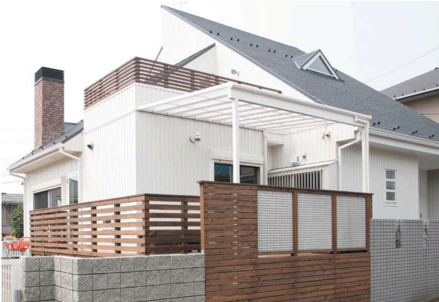
縦に流れる明るい白い外壁と、横に流れる木目が建物全体の印象をバランス良く仕上げています。
