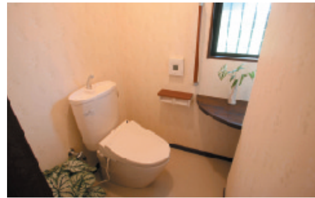
棚や手すりを施工し介護のスペースを考慮したトイレ。
