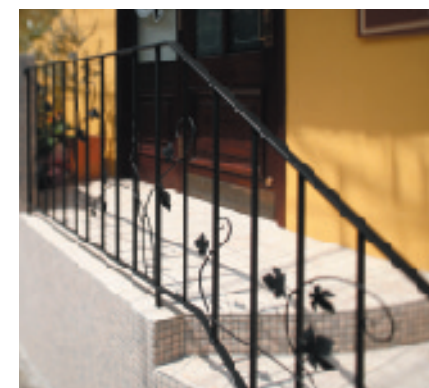
オリジナルで作成した手すり。
