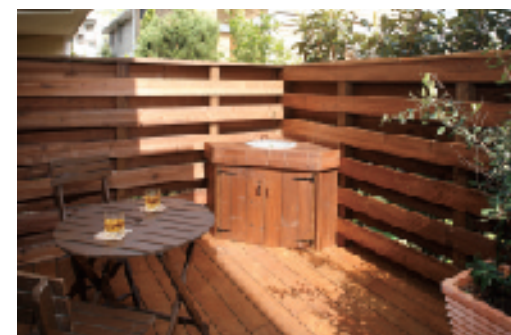
デッキシンクはウッドデッキ材を加工してカウンター・キャビネット収納・扉を造作しました。
