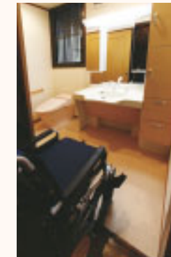
段差の無い広い間口。
