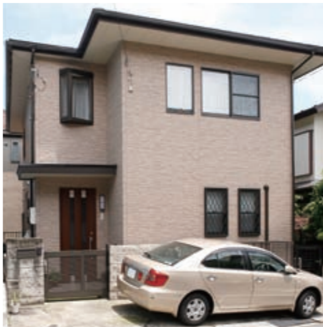
外壁に明るい色彩の石肌調を使用し、表情のある外観に。
