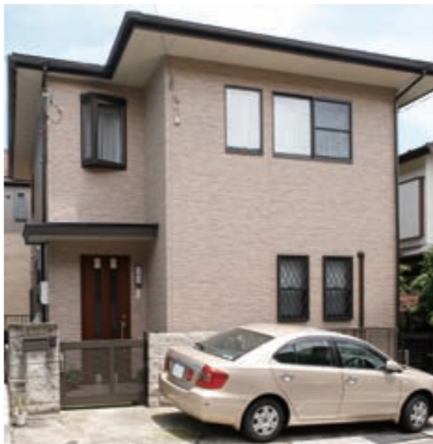
外壁に明るい色彩の石肌調を使用し、表情のある外観に。
