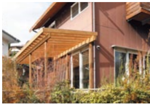
バーゴラを設置し、既存部分との統一感を出しました。
