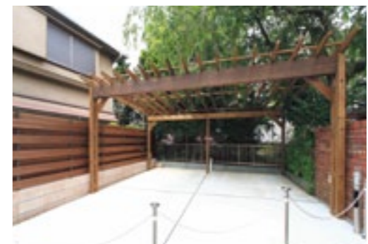
塀は交互張りにする事でプライバシーを守りながらも、 風が通り抜けるよう工夫しました。
