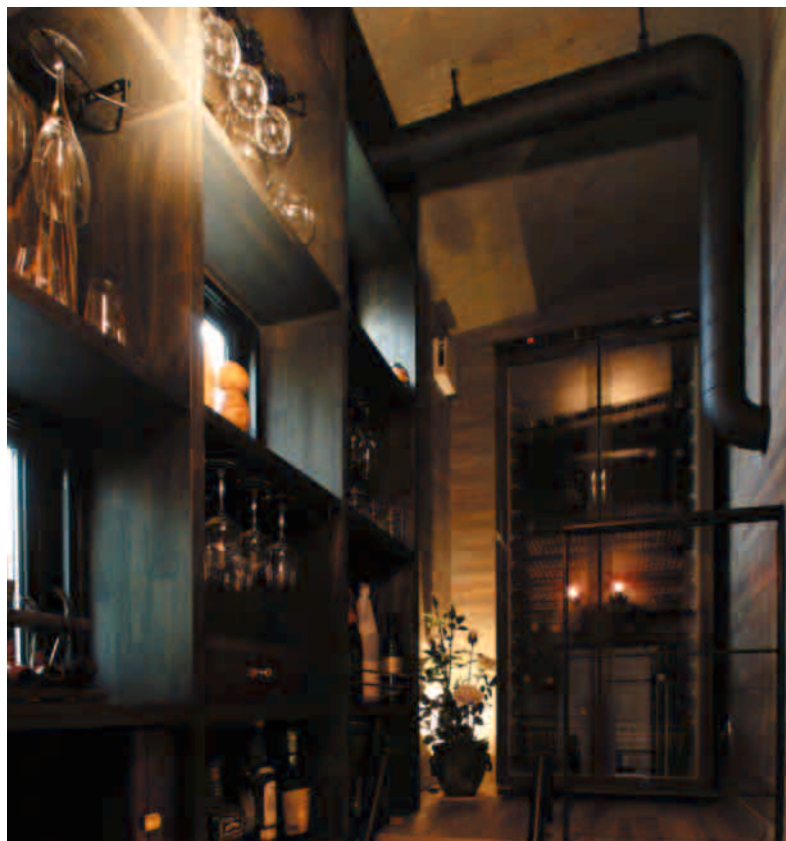
壁厚を利用して、ボトルやグラスを収納する為の棚を造作。
