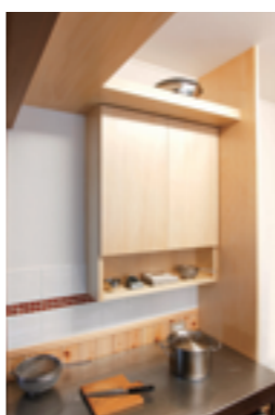
収納は、櫛の羽目板に合う シナベニヤのクリアー仕上げ。
