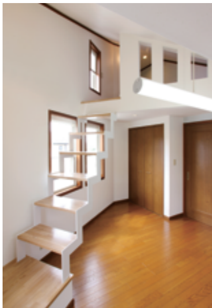
ロフトへ続く、視線を遮らないストリップ階段。
