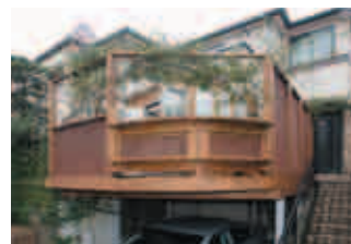
道路から見上げたデザインフェンス。 既存のものを復元しました。
