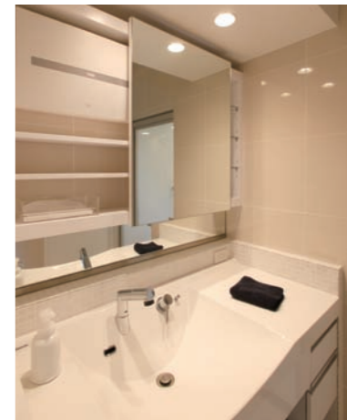
可動鏡を右に寄せると分電盤と収納、左に寄せると窓の開閉が可能。
