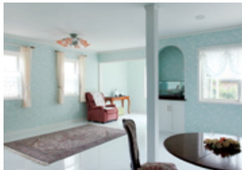
窓枠・幅木・廻縁などは面加工を施したモールを使用し、統一感があります。
