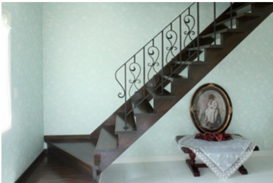
リビングの一角にロートアイアンの手摺を設置した木製の階段は、インテリアのアクセントに。
