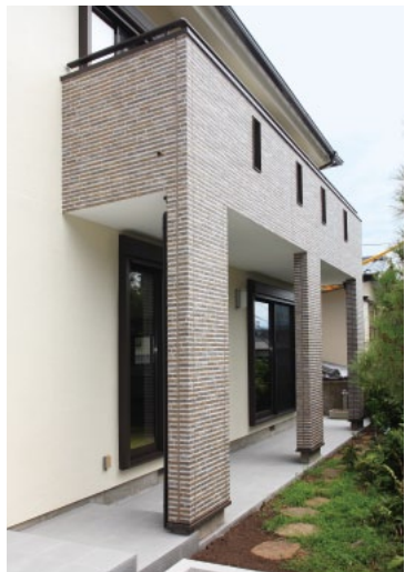
石目調の外壁と、床のタイルで迫力あるルーフバルコニーに。
