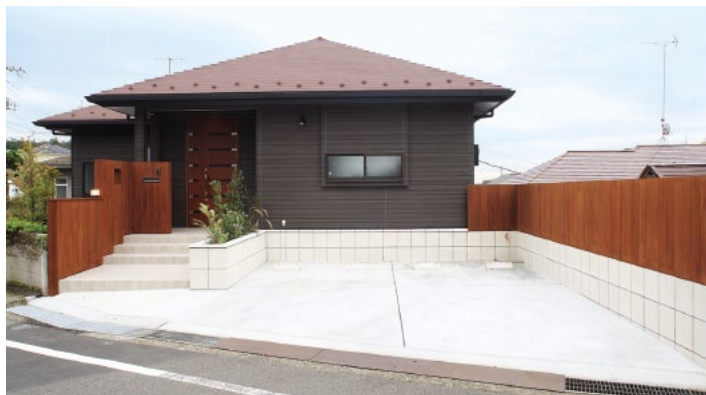
エントランスへと動きやすい、車2台分の駐車スペース。
