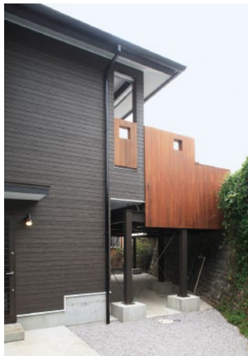
車庫下はコンクリートで補強しており、作業スペースとしても利用出来ます。
