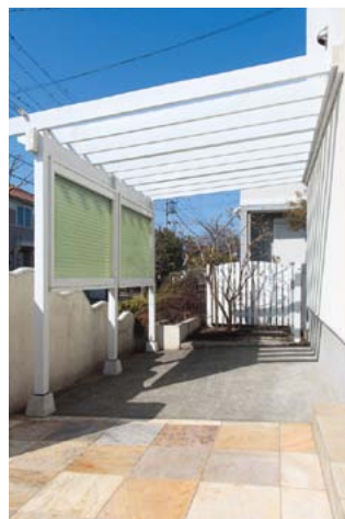
強化ガラスを取り付けたパーゴラで、風雨を防ぐ自転車置き場。
