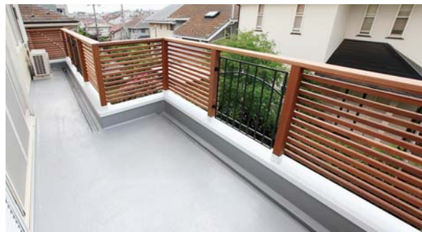
床は、FRP防水仕上げ。開放感が得られる手摺デザイン。
