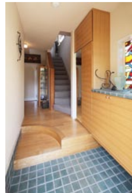
扉を交換し、カウンターにタイルを貼り、既存玄関収納をリメイク。
