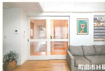
一階からロフトまでつながる階段。冷暖房効率とお子様安全性を考慮して、鍵付きの間仕切り建具を設置。光が抜け、姿も確認できるデザイン。必要に応じて全開口もできます。
